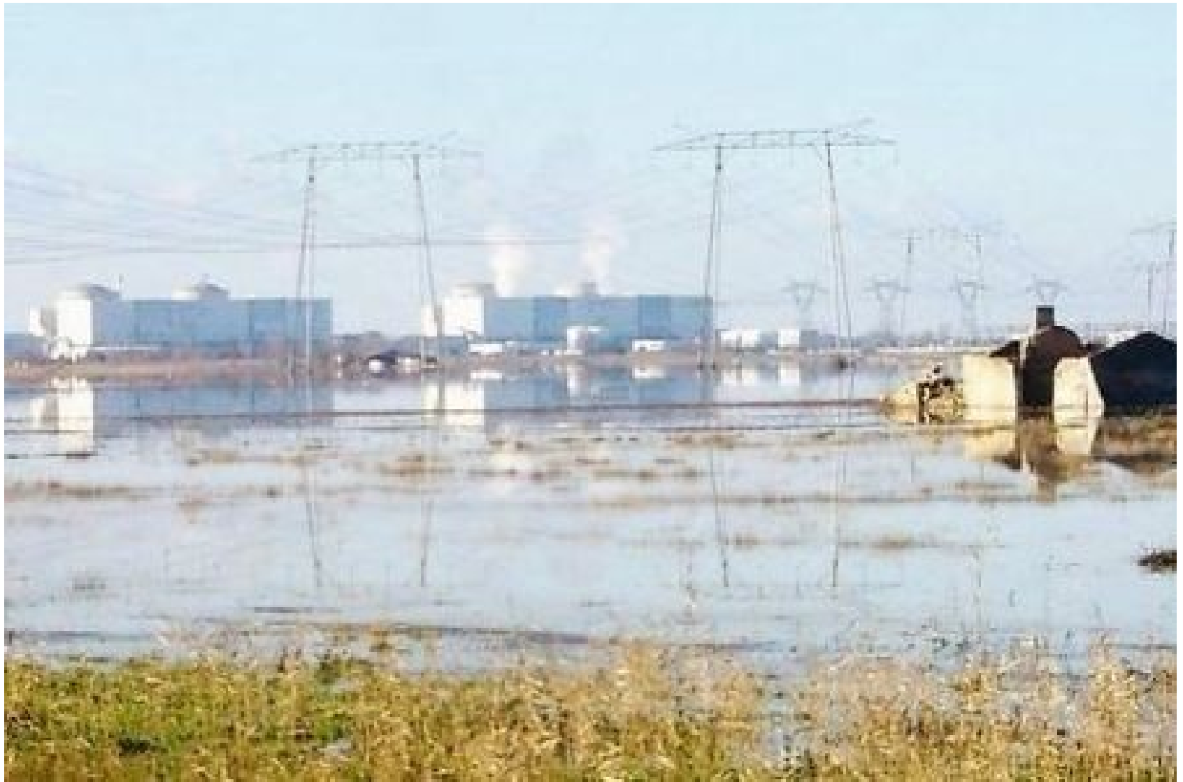
La centrale du Blayais 28/12/1999
